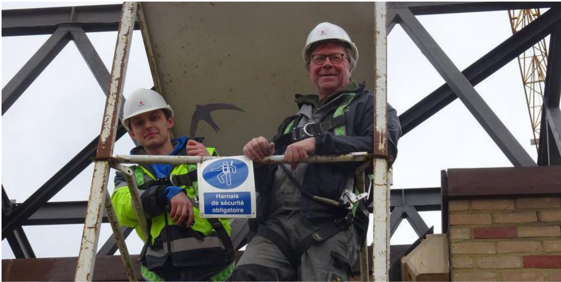
Des nichoirs compensatoires ont été installés. © D.R.
